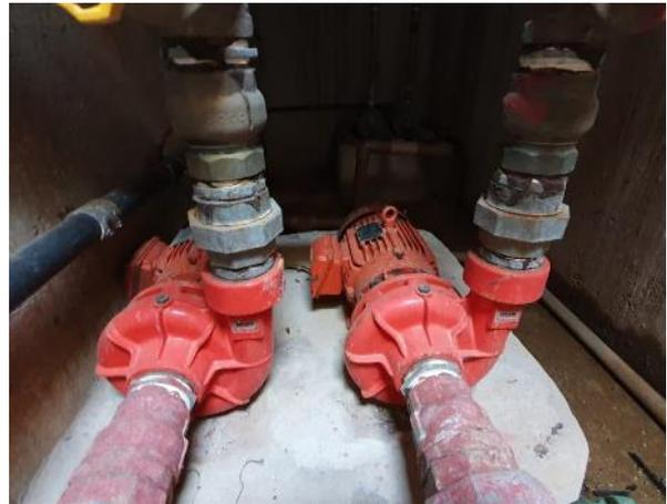
*Foto 18 – Bombas do sistema de combate a incêndio inoperantes*
