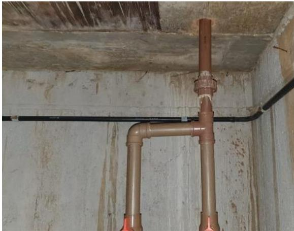
*Foto 13 – Tubulação de recalque*
