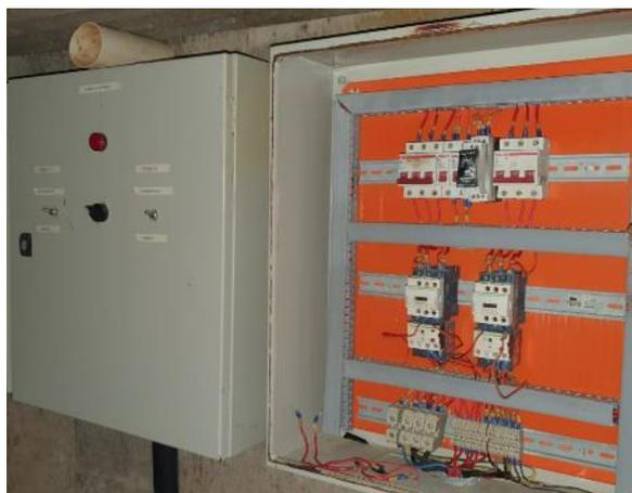
*Foto 25 – Quadros de comando dos sistemas de recalque e combate a incêndio com dispositivos danificados devido a umidade*
