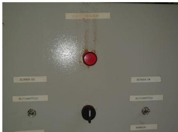
*Foto 26 – Quadros de comando dos sistemas de recalque e combate a incêndio danificados*
