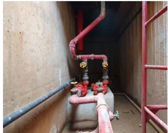
*Foto 20 – Bombas do sistema de combate a incêndio inoperantes*
