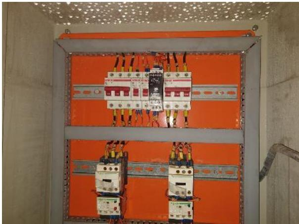
*Foto 23 – Quadros de comando dos sistemas de recalque e combate a incêndio com dispositivos danificados devido a umidade*
