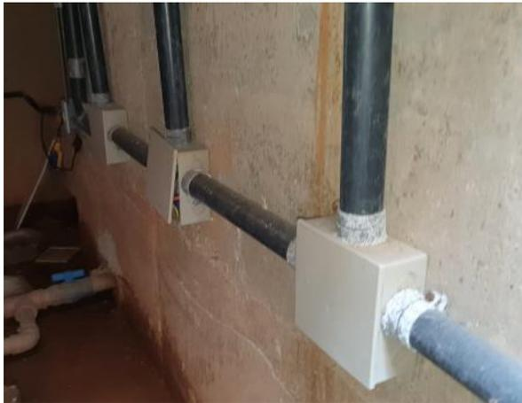
*Foto 21 – Tubulação de alimentação dos quadros de comando*
