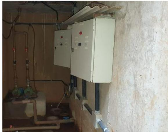
*Foto 22 – Tubulação de alimentação dos quadros de comando*
