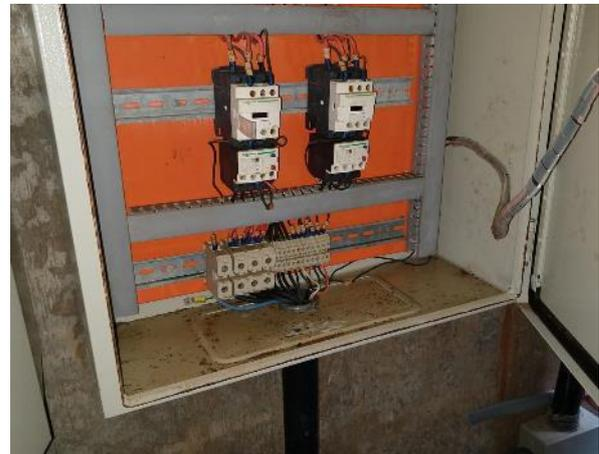
*Foto 24 – Quadros de comando dos sistemas de recalque e combate a incêndio com dispositivos danificados devido a umidade*
