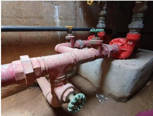
*Foto 17 – Bombas do sistema de combate a incêndio inoperantes*
