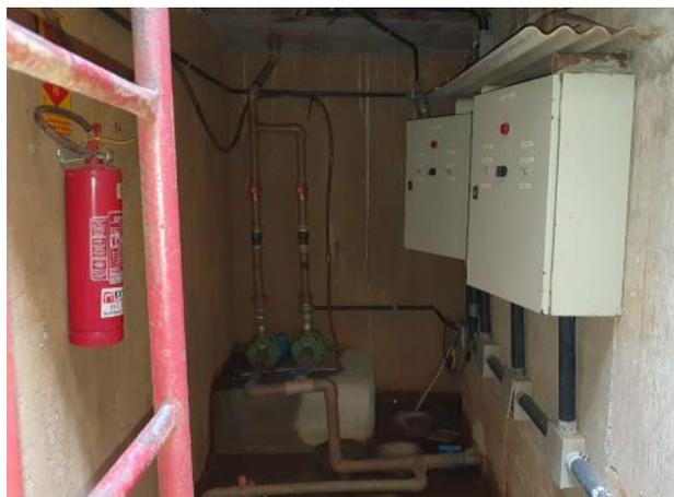
*Foto 07 – Quadros de comandos e bombas de recalque na casa de bombas subterrânea*
