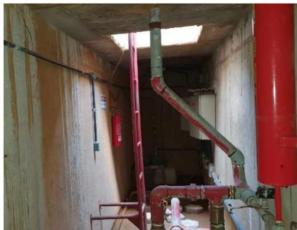
*Foto 08 – Quadros de comandos e bombas de recalque na casa de bombas subterrânea*
