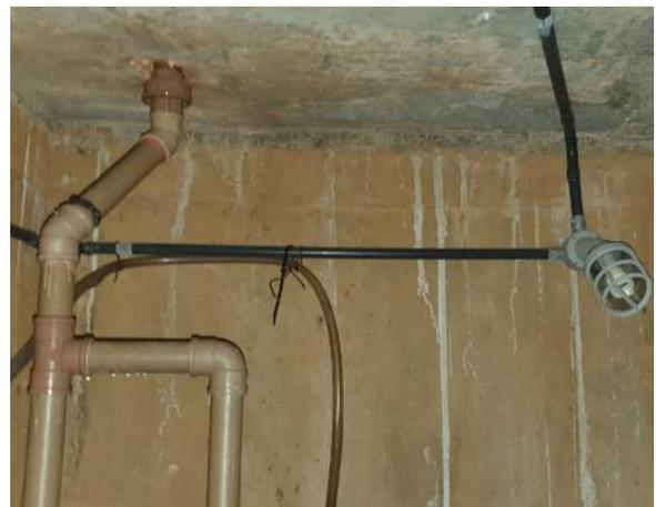
*Foto 12 – Fiação de alimentação das bombas de recalque e iluminação*
