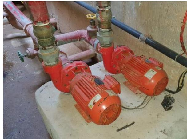
*Foto 16 – Bombas do sistema de combate a incêndio inoperante*
