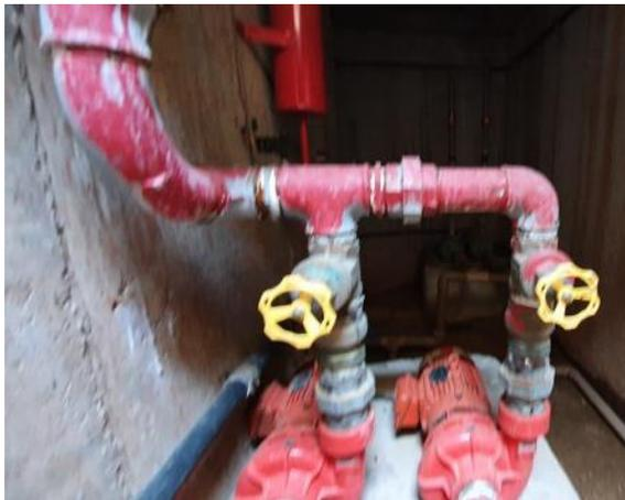
*Foto 19 – Bombas do sistema de combate a incêndio inoperantes*
