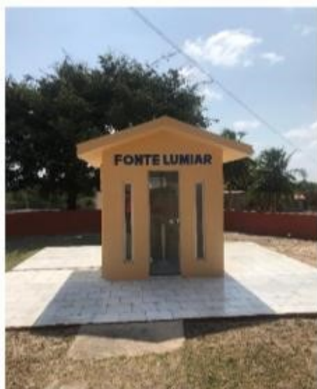
Casa de Proteção
