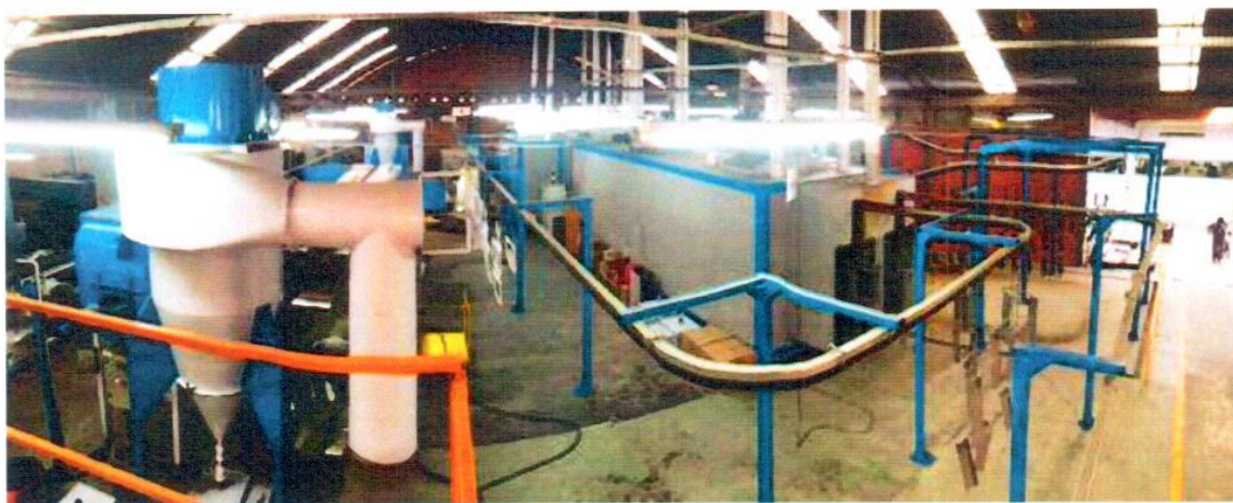
Figura 01. Panorâmica da linha de pintura da empresa
