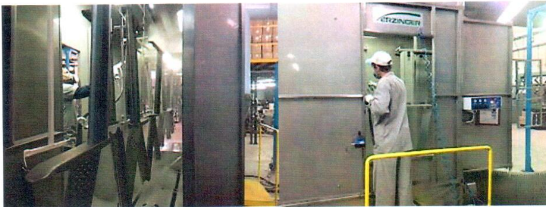
Figura 08. Cabine de pintura a Pó
