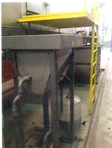
Fig. 03. Sistema de separação de óleo do banho
