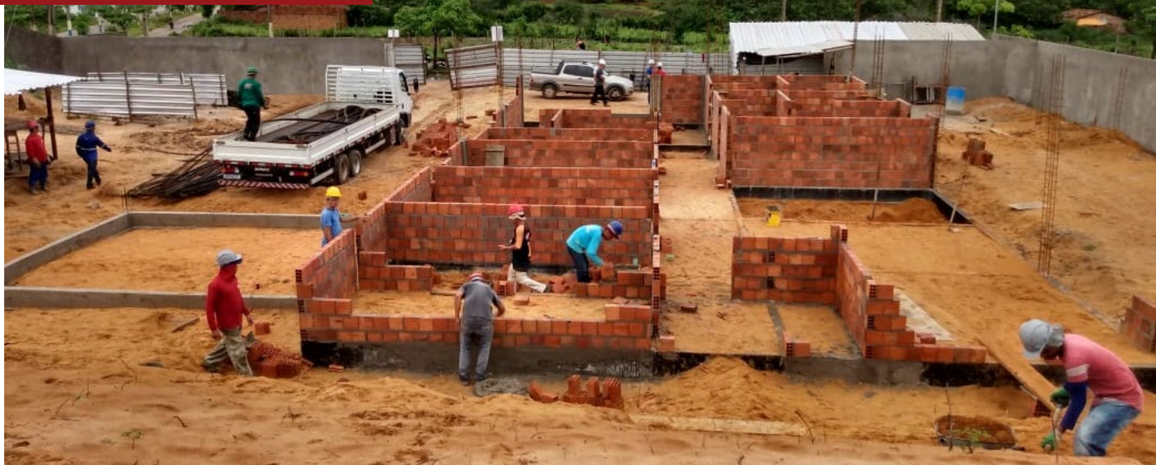
CONSTRUÇÃO DA SEDE DA PROMOTORIA DE JUSTIÇA DE ARAIOSES
