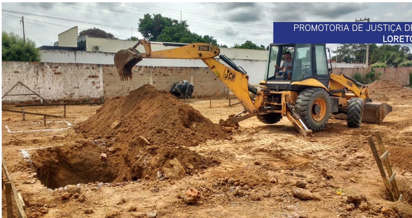
CONSTRUÇÃO DA SEDE DA PROMOTORIA DE JUSTIÇA DE LORETO
