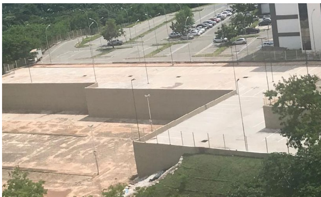
CONSTRUÇÃO DO ESTACIONAMENTO DAS PROMOTORIAS DE JUSTIÇA DA CAPITAL
