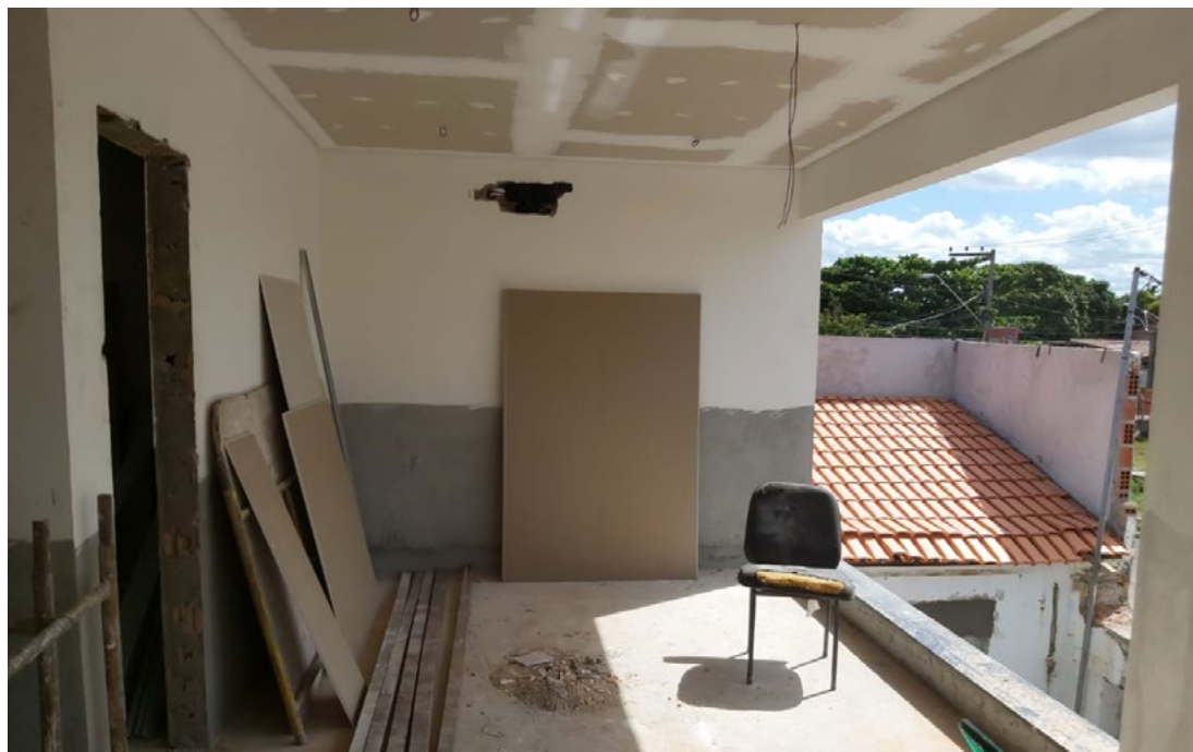
CONSTRUÇÃO DO CIRA - IMPERATRIZ
