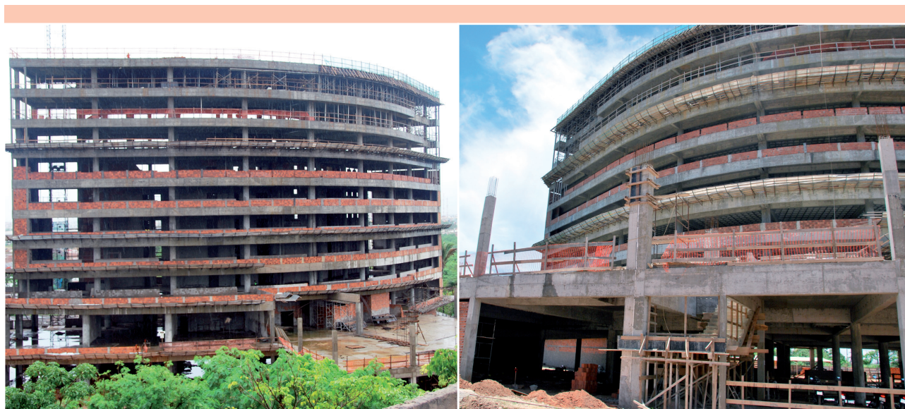
Construção do prédio da Procuradoria Geral de Justiça
