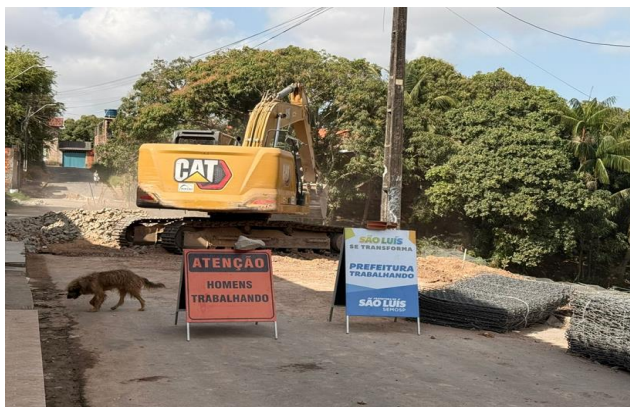
Após intervenção da PJ Itinerante, a Rua Projetada foi recuperada pela SEMOSP
